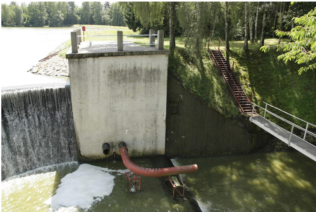
Foto.9. Pohled levý pilíř přelivu s výpustným potrubím, ocelovou lávku a schodiště a místo na levém břehu vývaru určené k umístění zařízení staveniště
