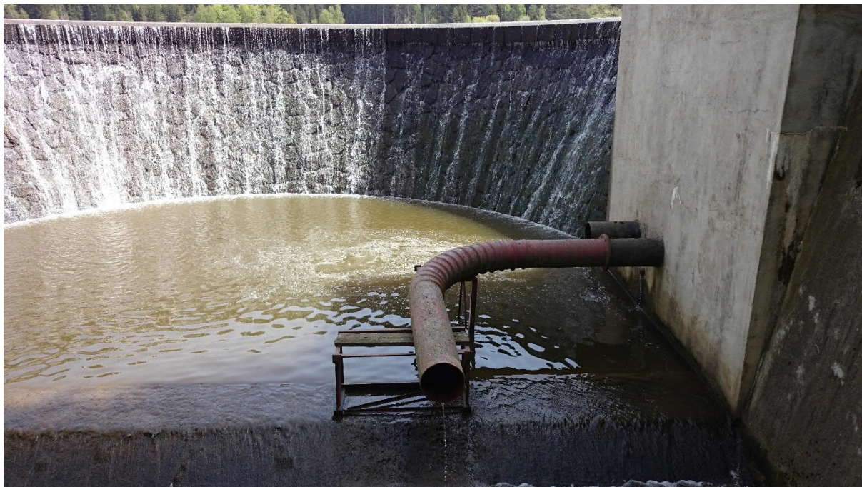
Foto.5. Pohled na vývar s vyústěním spodních výpustí
