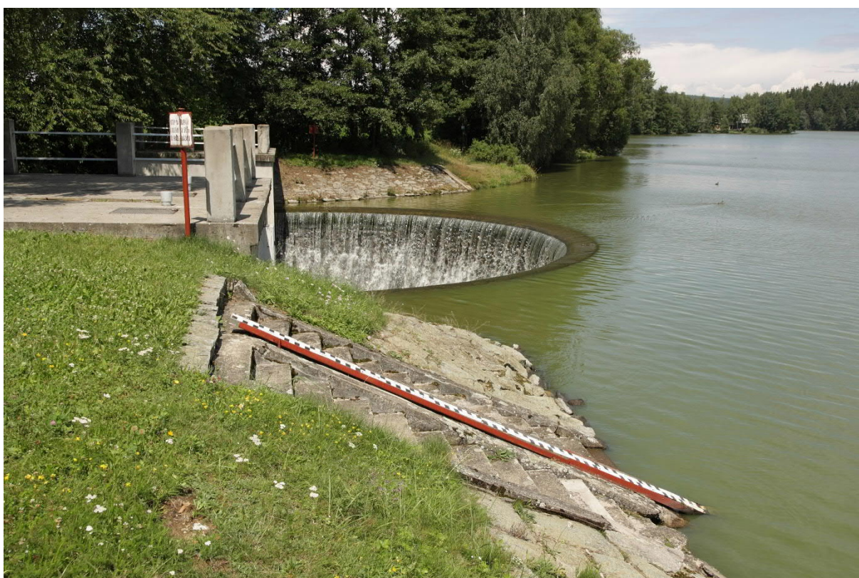
Foto.4. Pohled na bezpečnostní přeliv VD Strž
