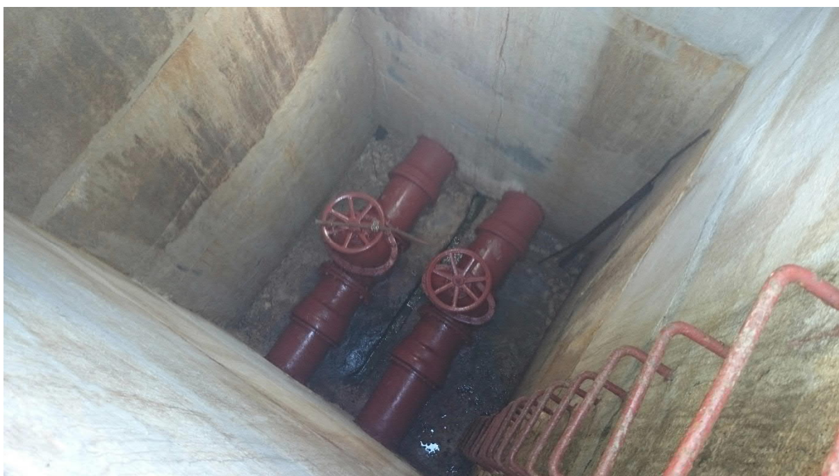
Foto.6. Pohled do povodňové šachty s dvěma regulačními šoupaty DN 400
