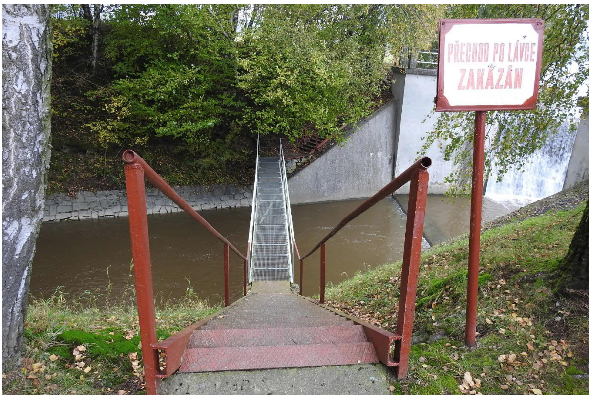
Foto.8. Pohled na ocelovou lávku na vývarech s navazujícími ocelovými schodišti
